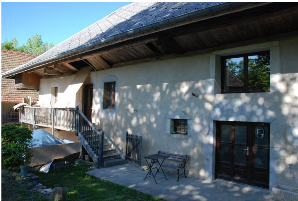
Vue d'ensemble (façade ouest).
