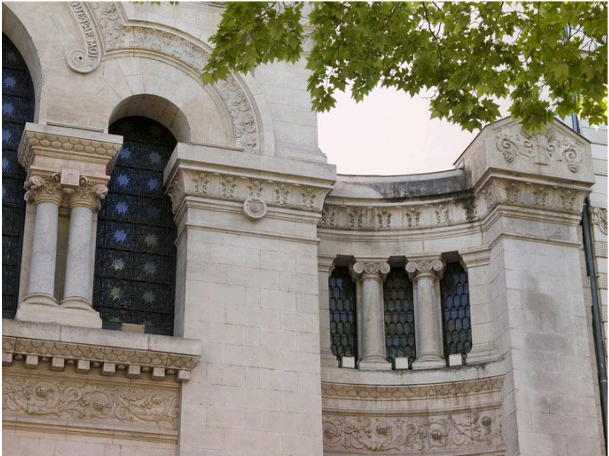
Façade antérieure : aile latérale sud.
