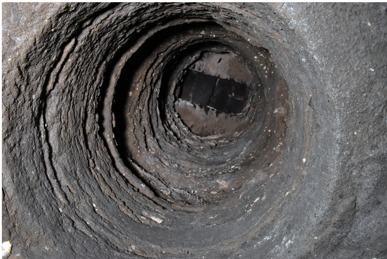
Caves nord, salle n°16 : puits communiquant avec la salle n°8 au niveau -1
