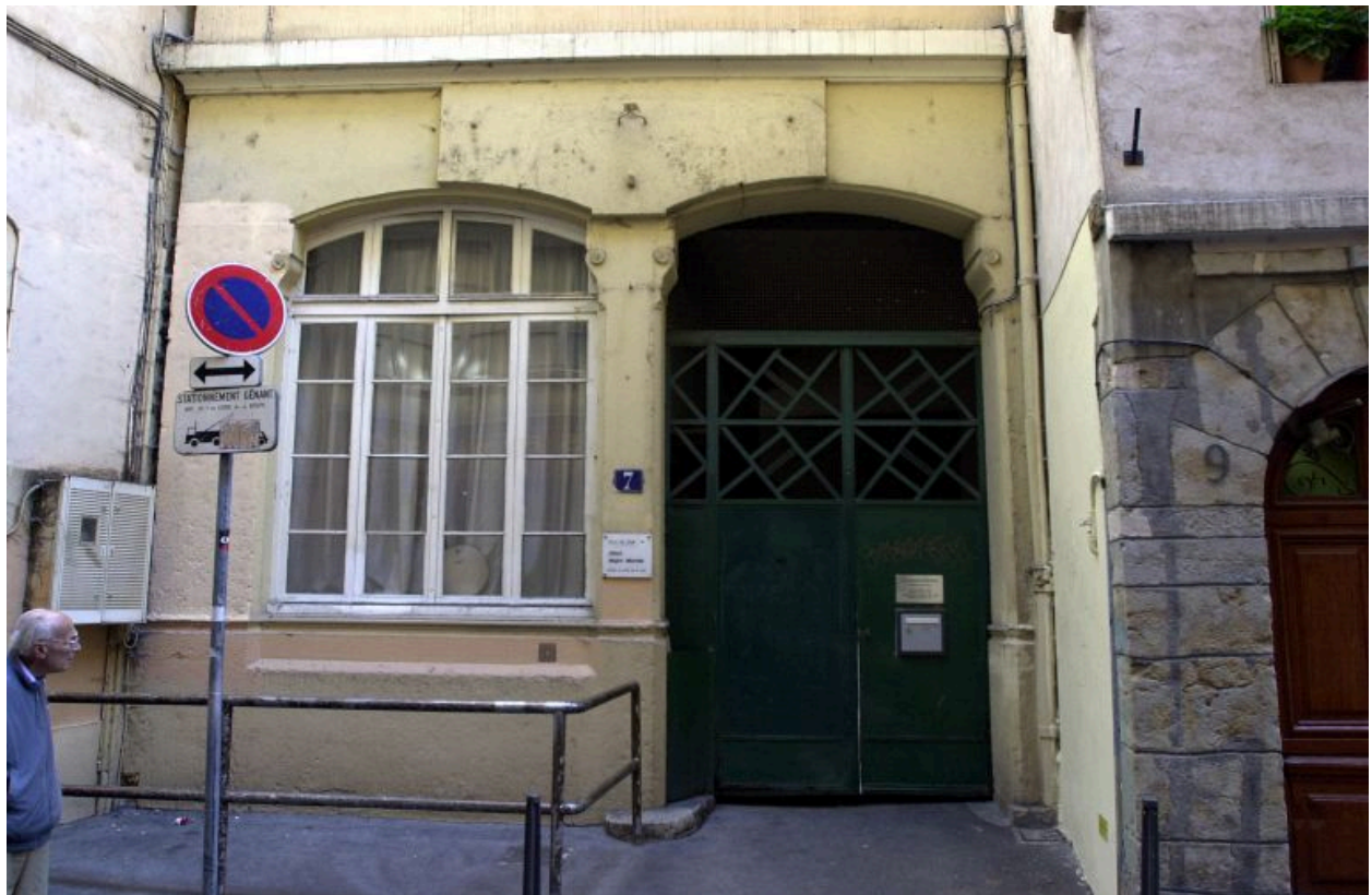
Façade sur rue, rez-de-chaussée
