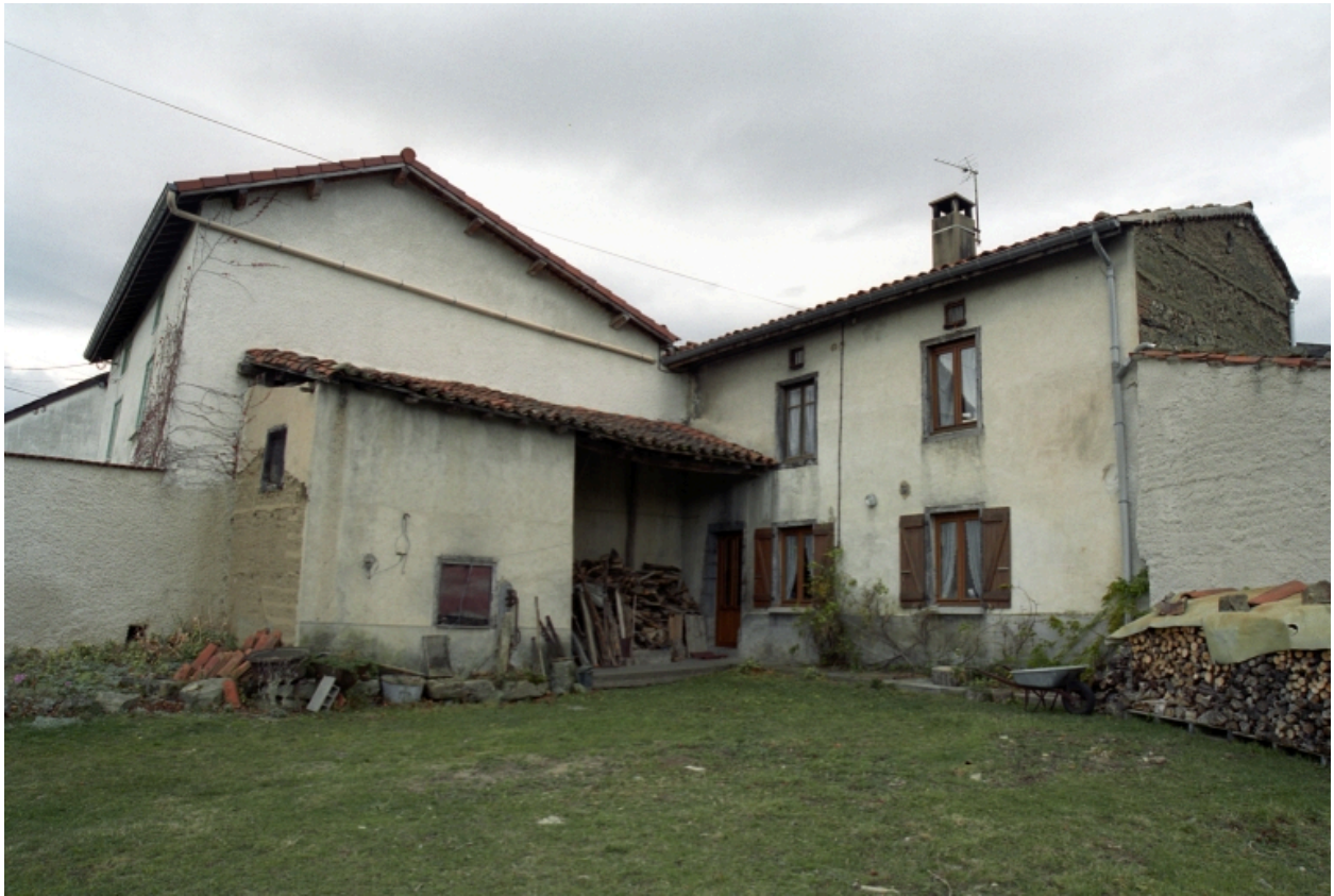
Vue d'une ferme du hameau de Ciergues (1987 D3 946).
