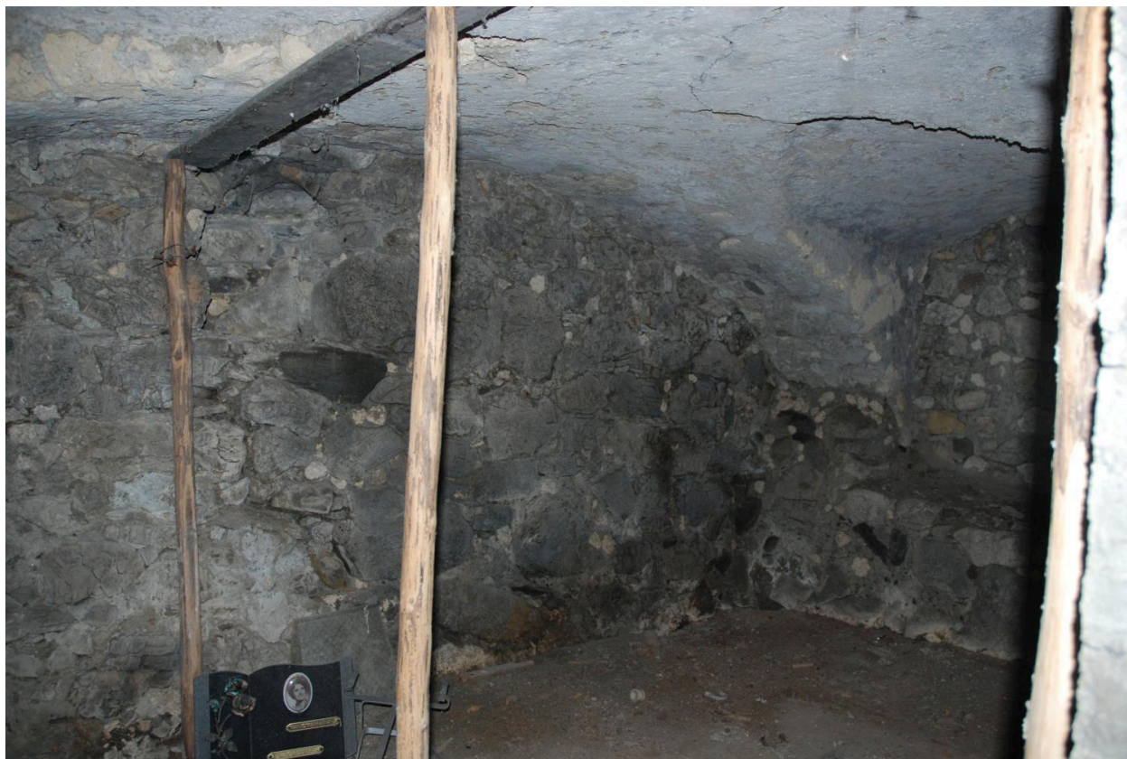
Vue intérieure de la cave sud-est.
