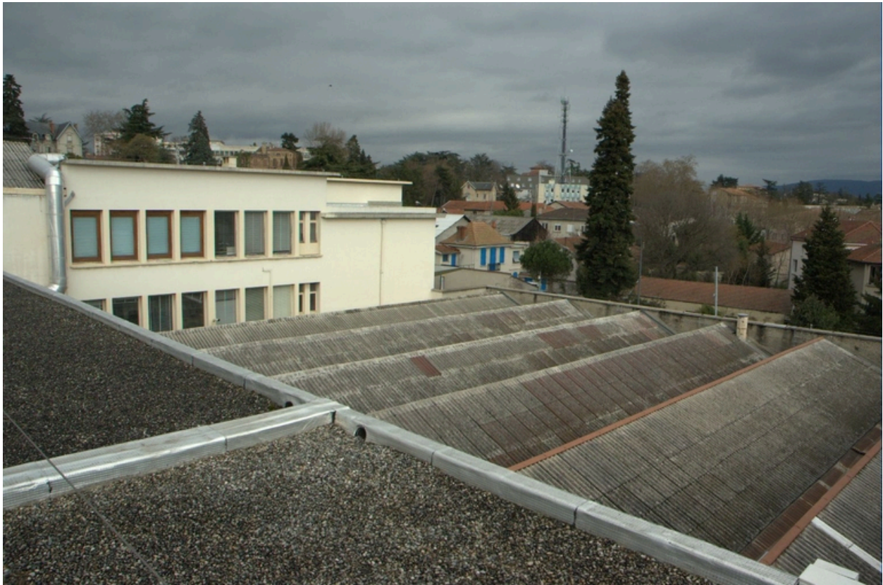
Vue des sheds
