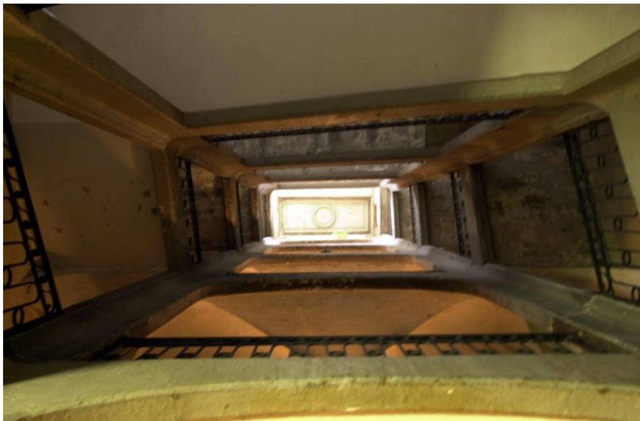
Vide de l'escalier vu depuis le rez-de-chaussée
