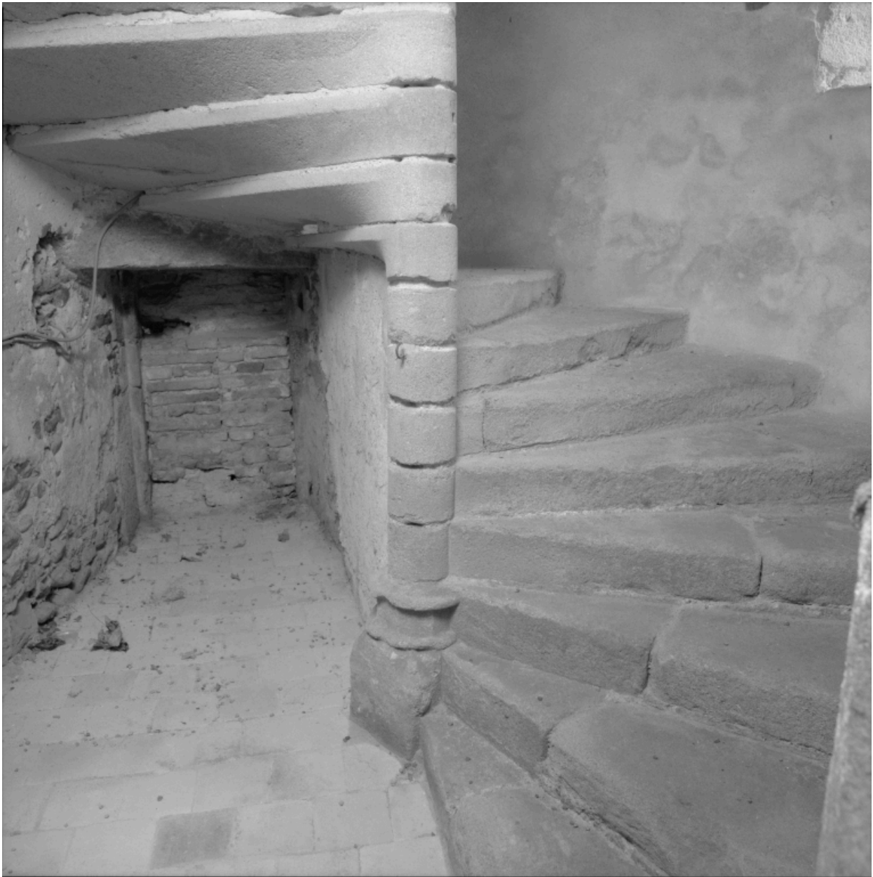
Corps de galerie, rez-de-chaussée : départ de l'escalier en vis situé dans la tour d'escalier nord-ouest.
