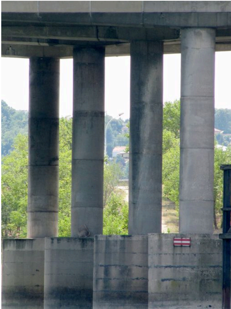
Pile, face amont (depuis la rive gauche)
