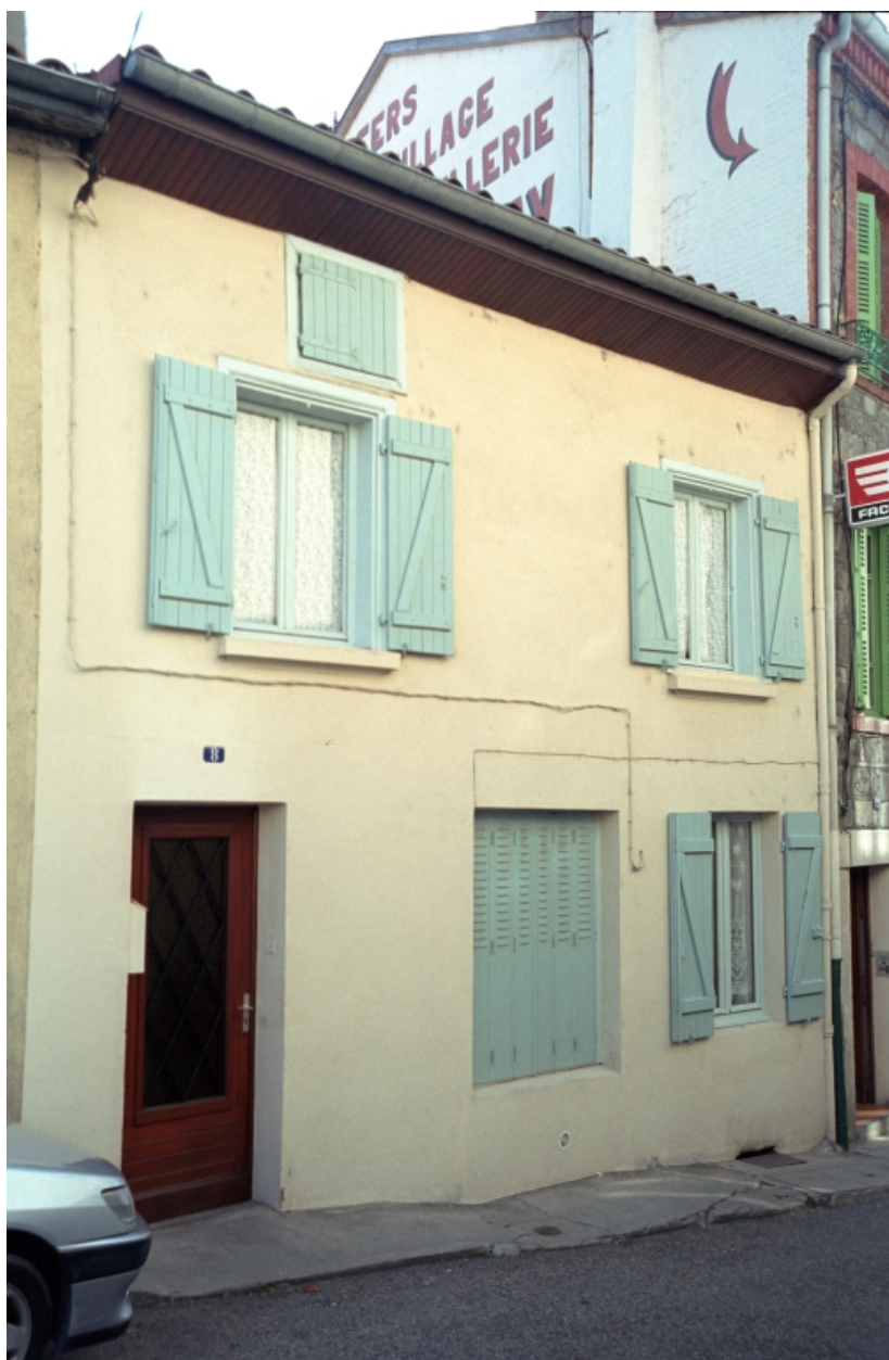
Boën, îlot 13, Ph. Raymond (rue) 8. Vue générale de la façade sur rue.
