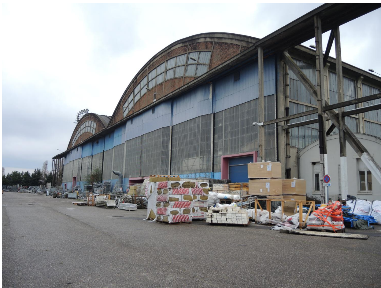
Hangar VI photo vue d'extérieur
