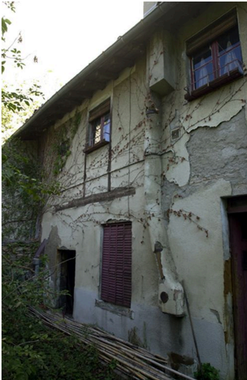
Elévation postérieure du corps de bâtiment nord
