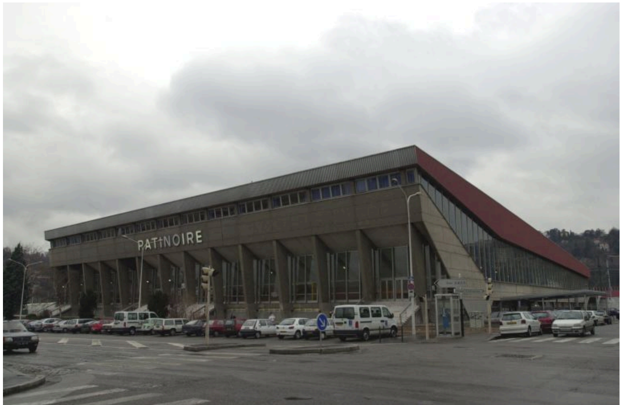
Façade principale et façade nord : vue d'ensemble
