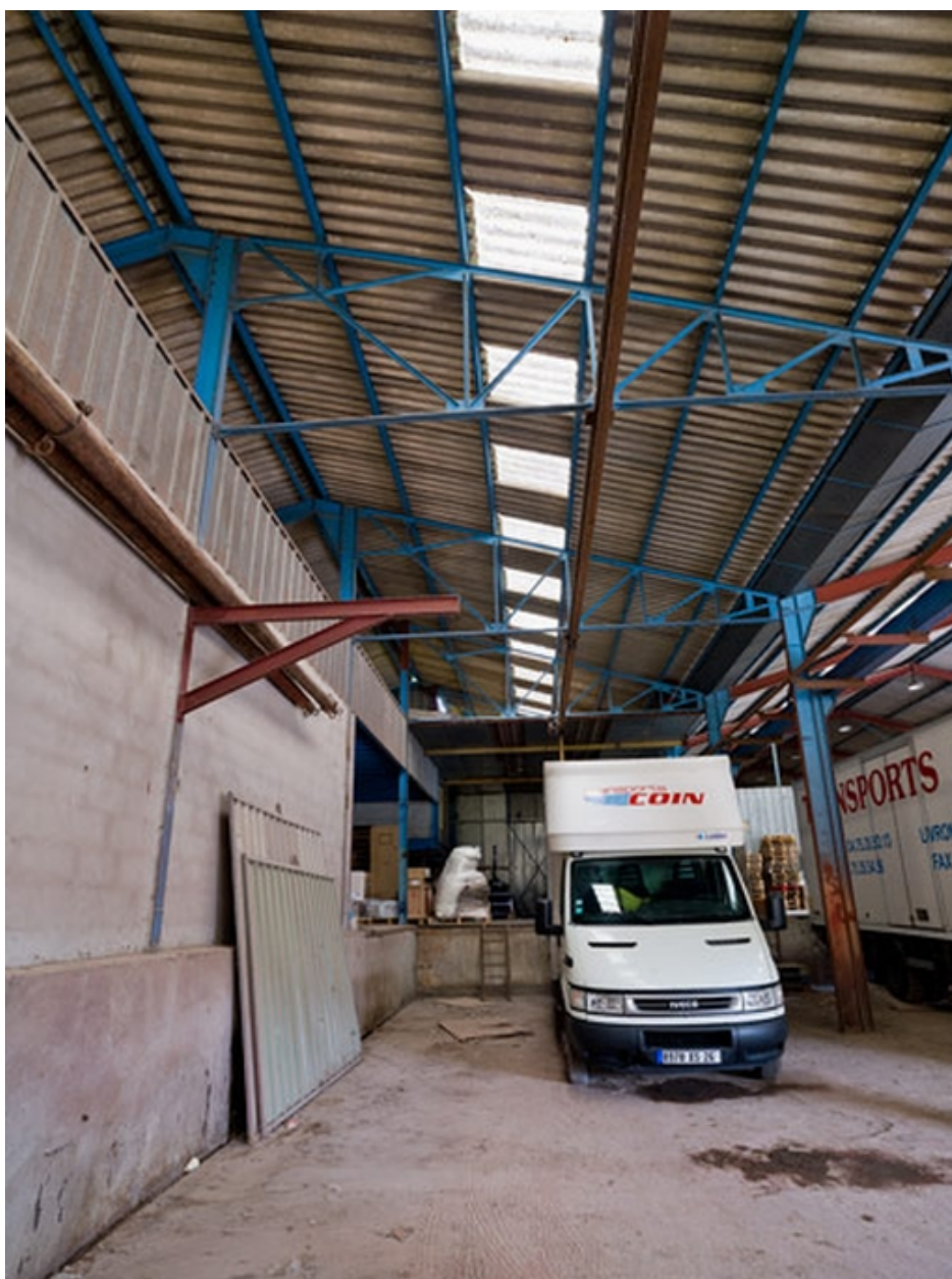
Détail intérieur des grands entrepôts
