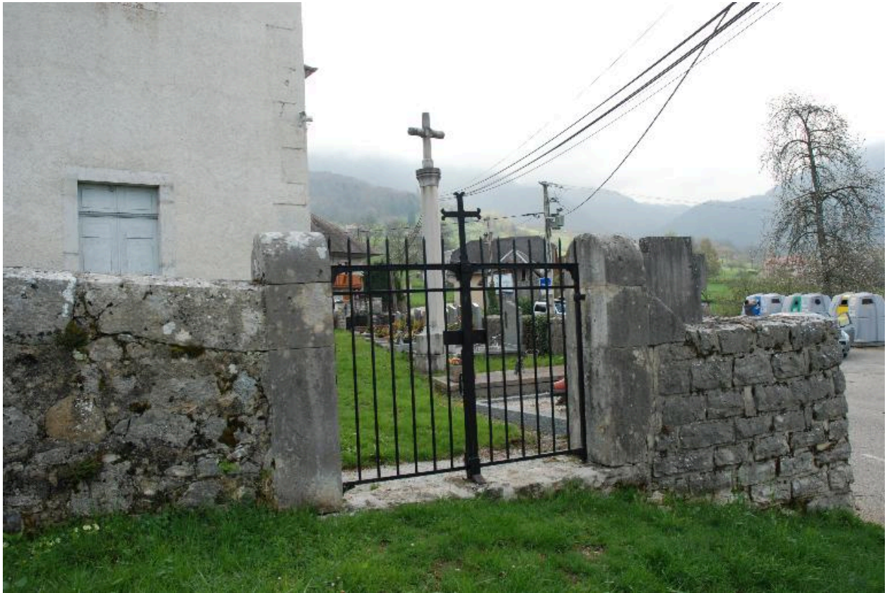
Vue du portail nord-ouest.
