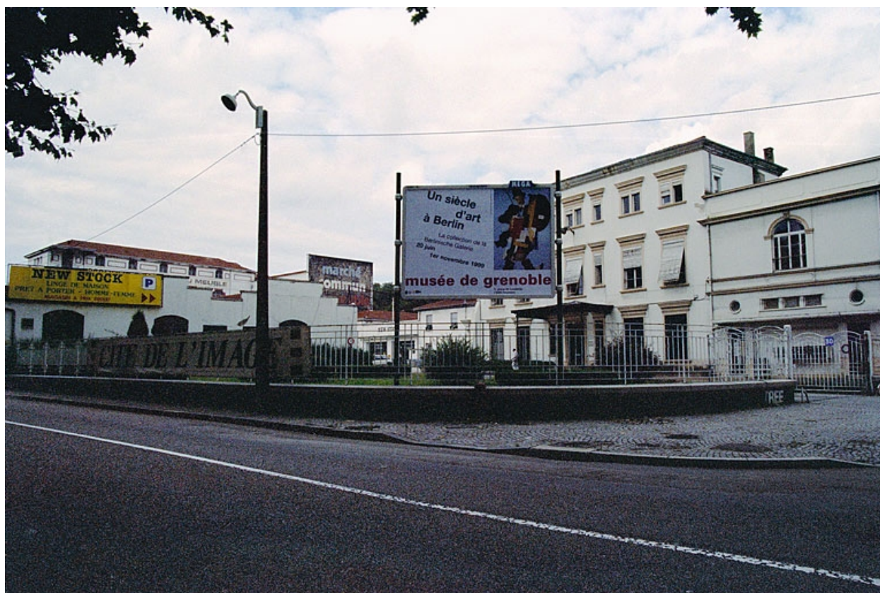
Vue d'ensemble nord-est, du quai de Saône
