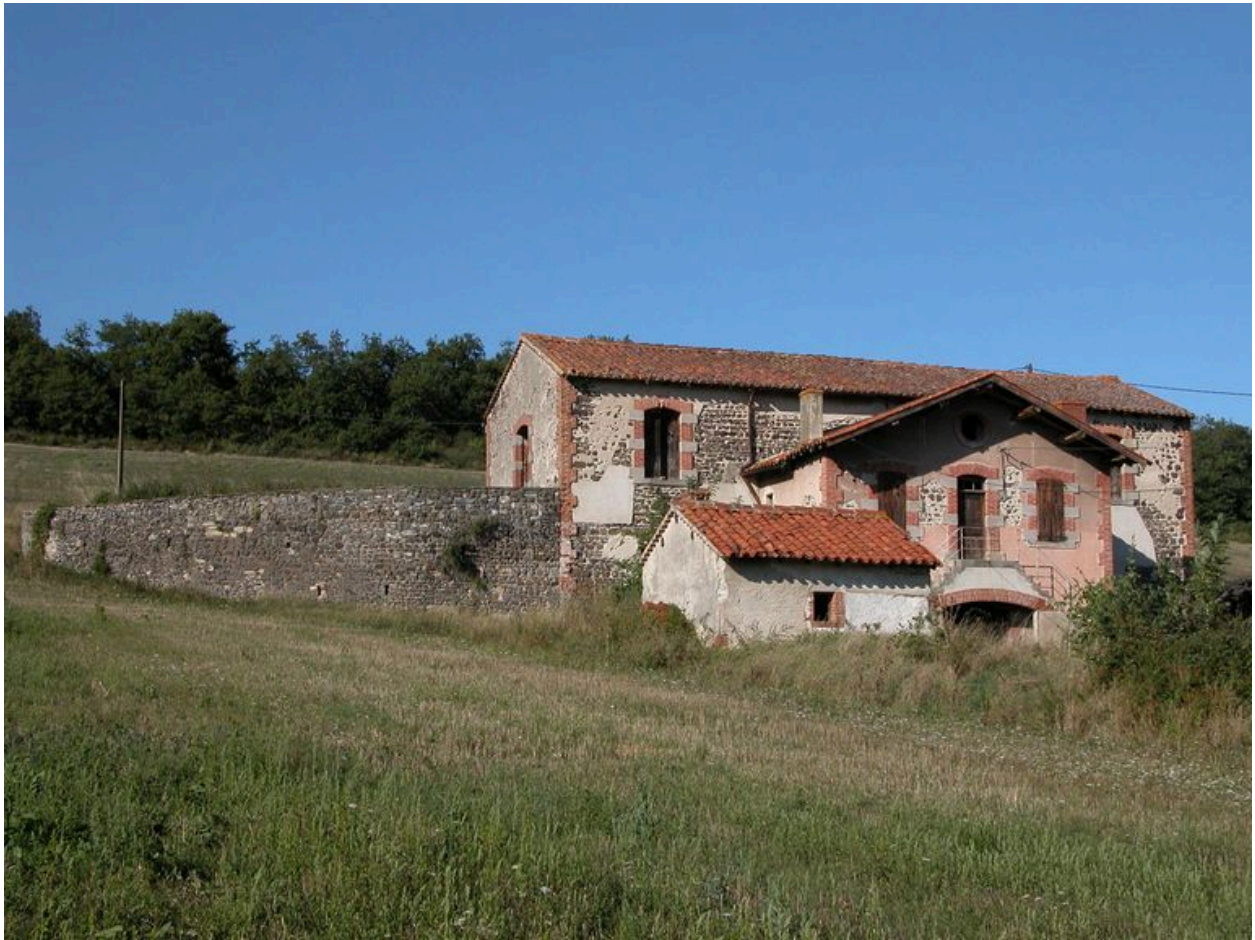
Vue d'ensemble du bâtiment principal depuis le sud-ouest.
