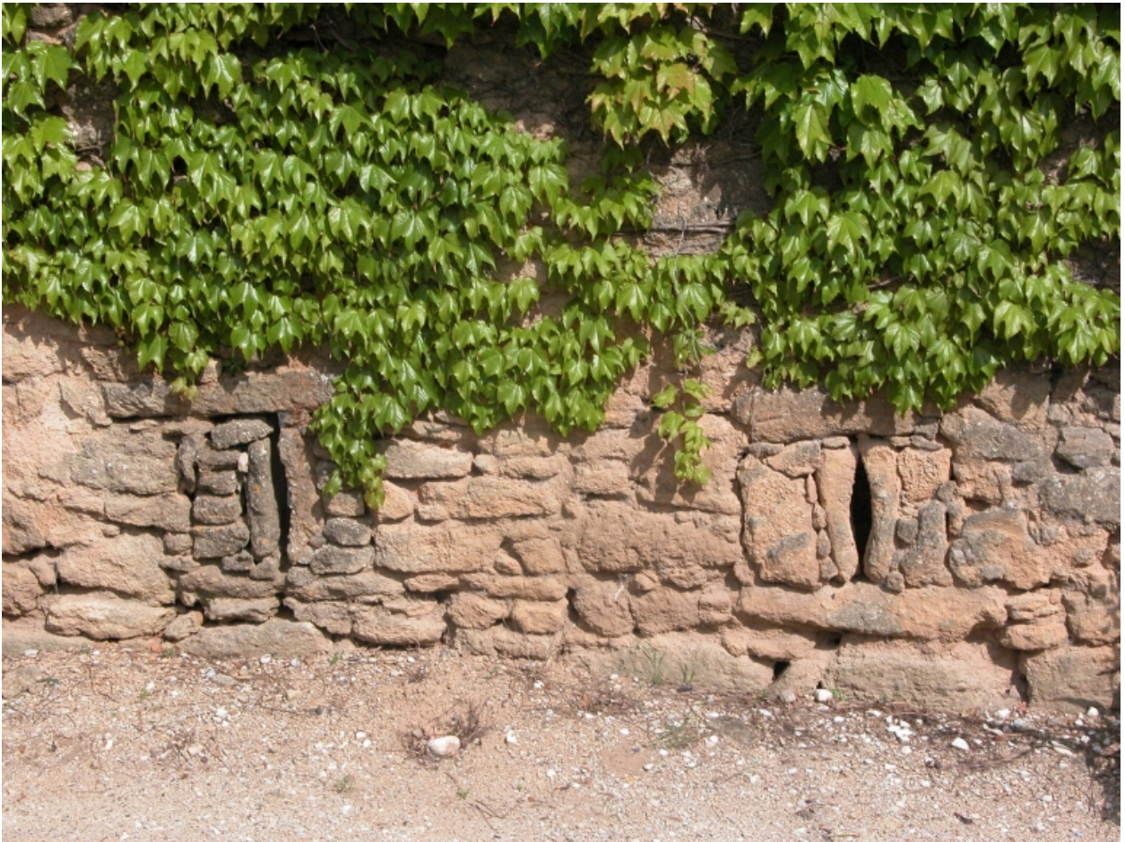
Margerie, route de Montségur, détails des jours des murs de dépendances d'une ferme (C3 681)
