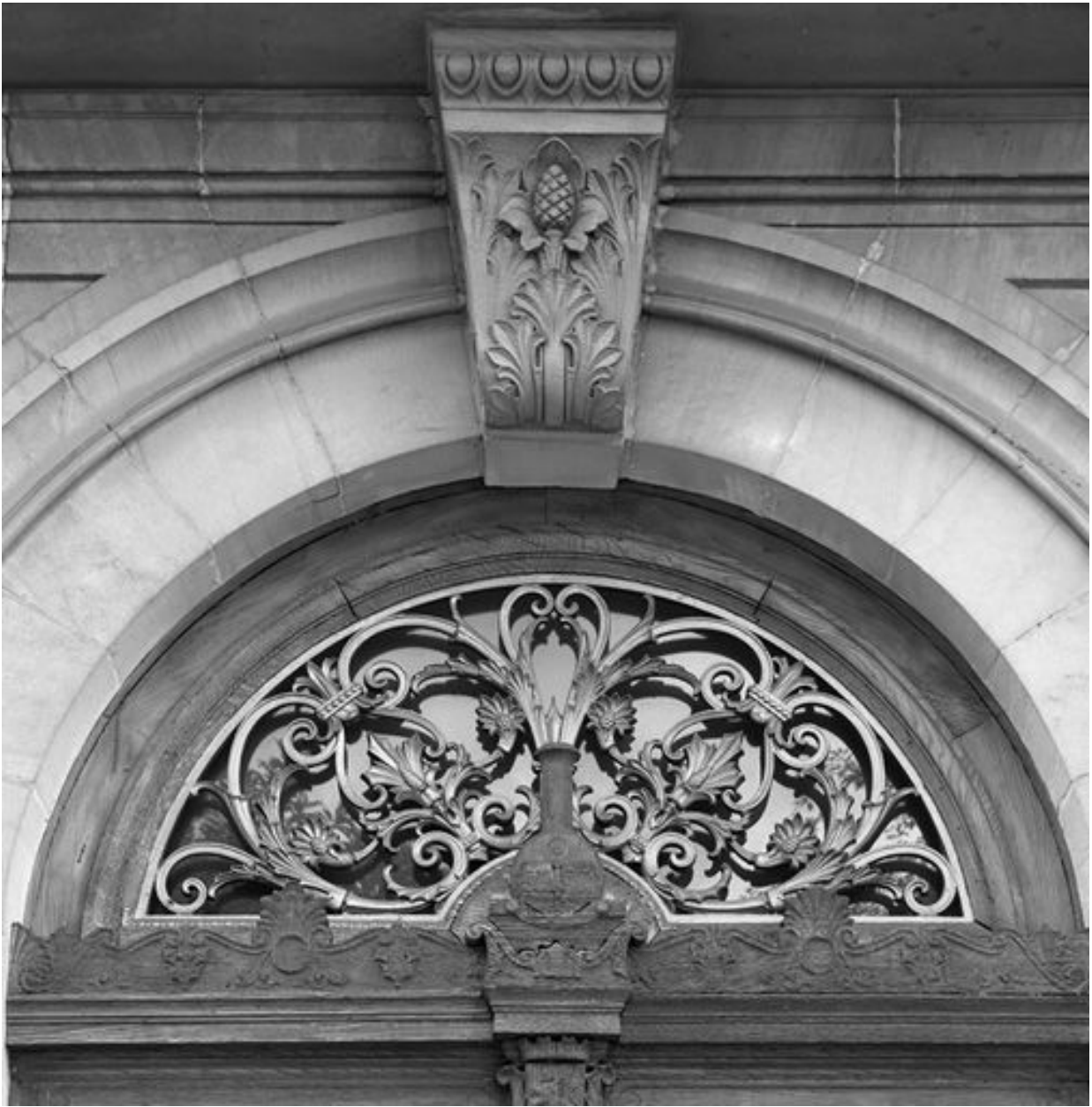
Porte d'entrée : châssis de tympan orné de rinceaux en ferronnerie
