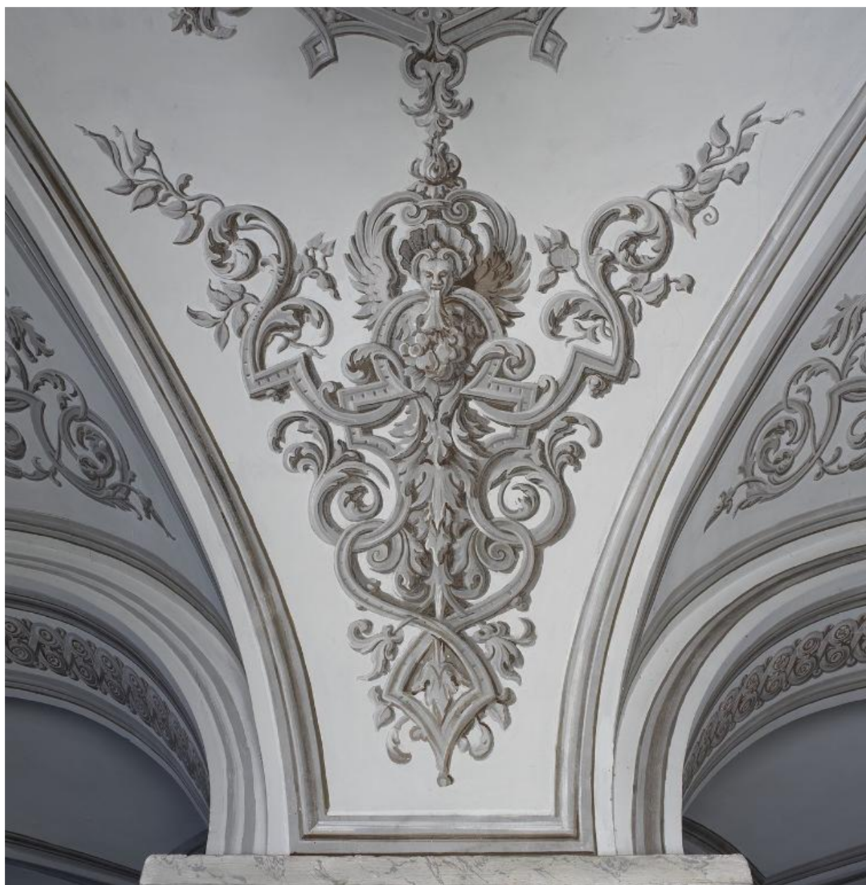
Détail d'un écoinçon au-dessus du pilier central.
