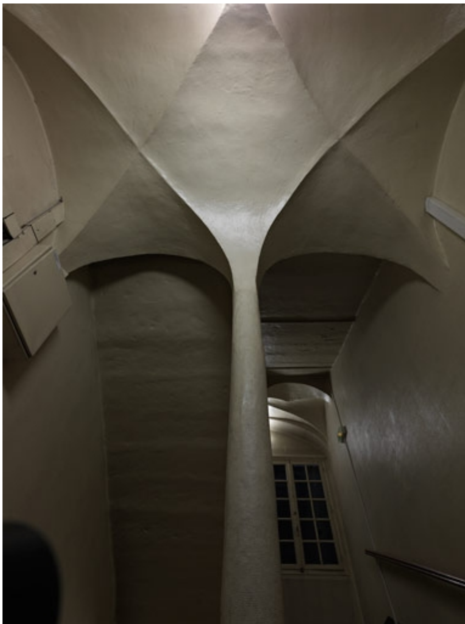
Bâtiment S nord. Escalier dit de la Cloche
