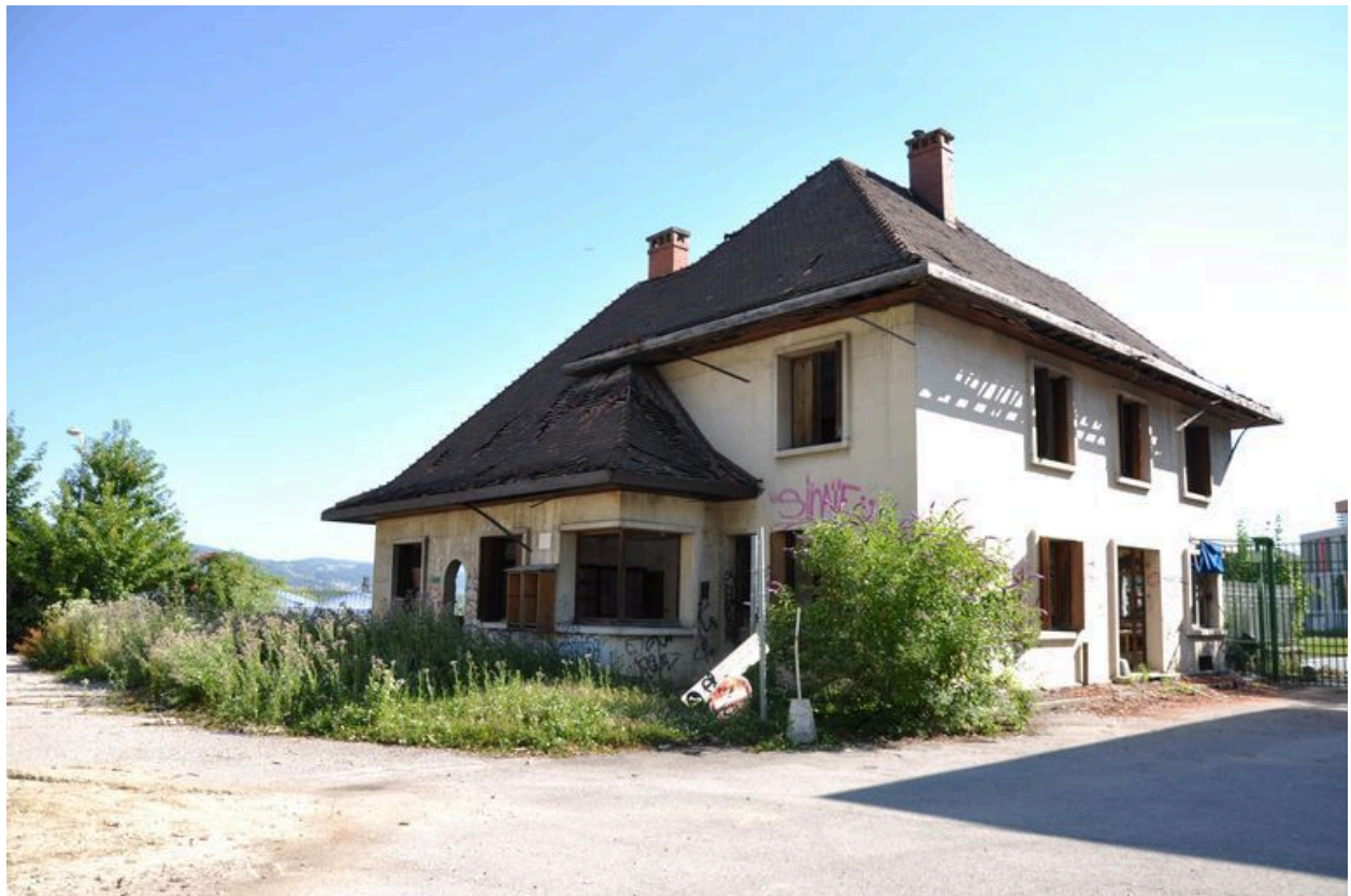
Elévation sud-ouest du bâtiment du poste de garde.
