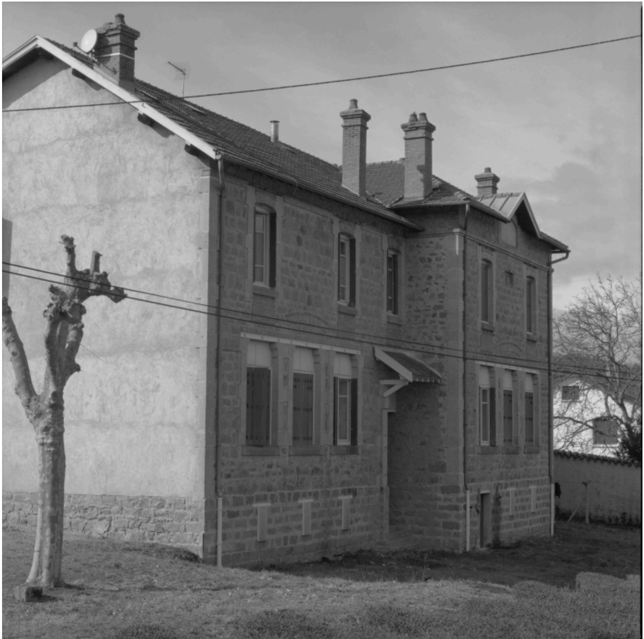
Vue d'ensemble de trois-quarts de la façade de l'école sur cour.
