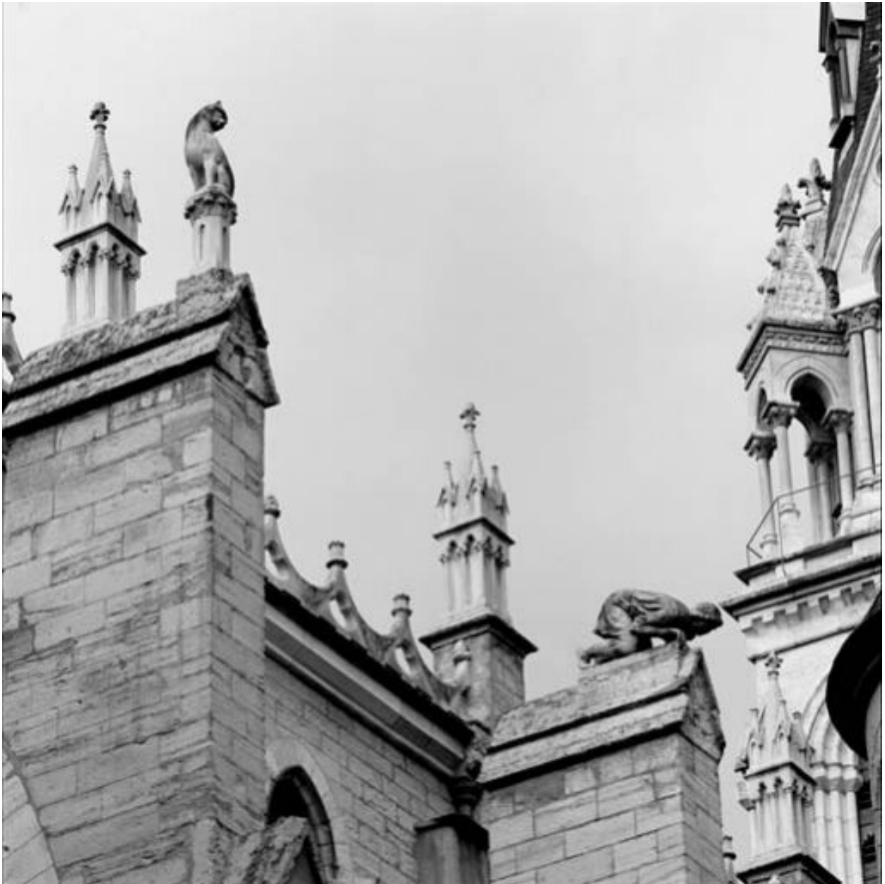
Élévation nord : détail de toiture et de sculptures
