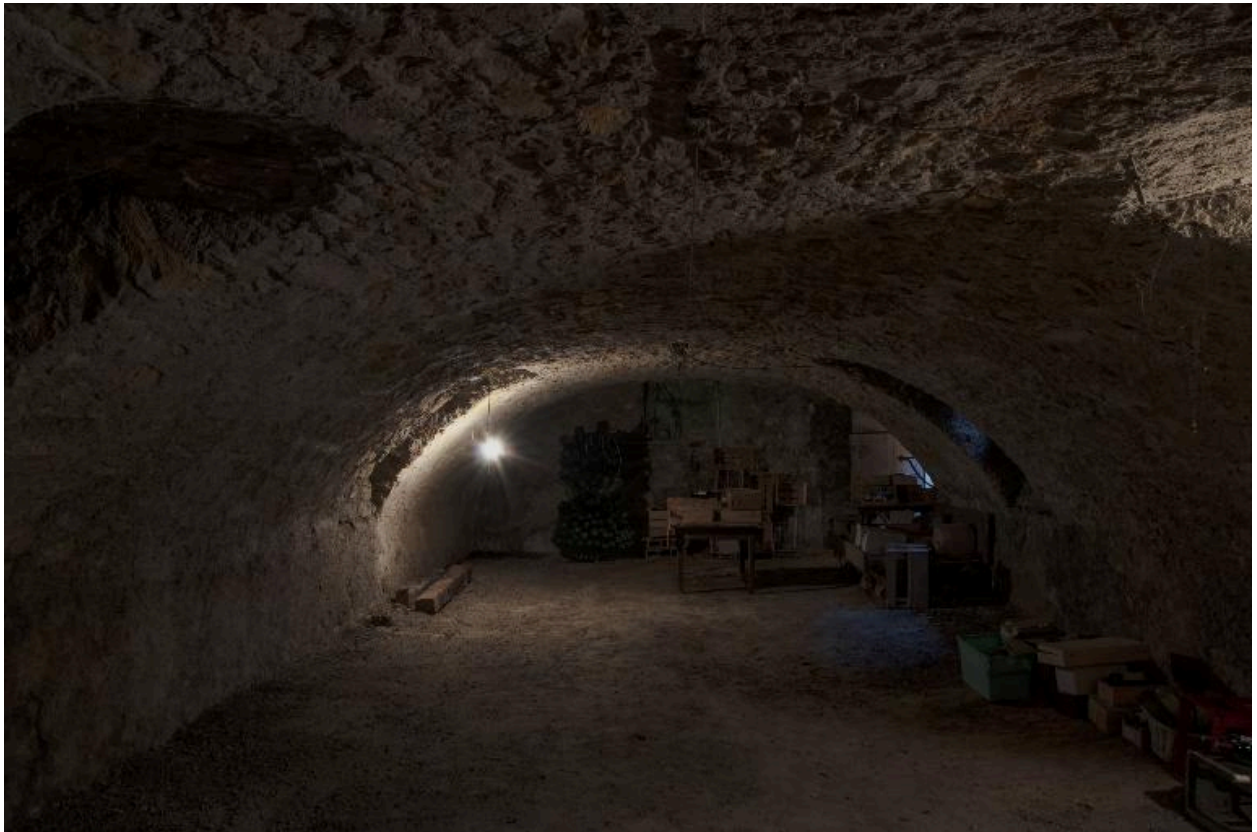
La cave voûtée, vue depuis l'ouest
