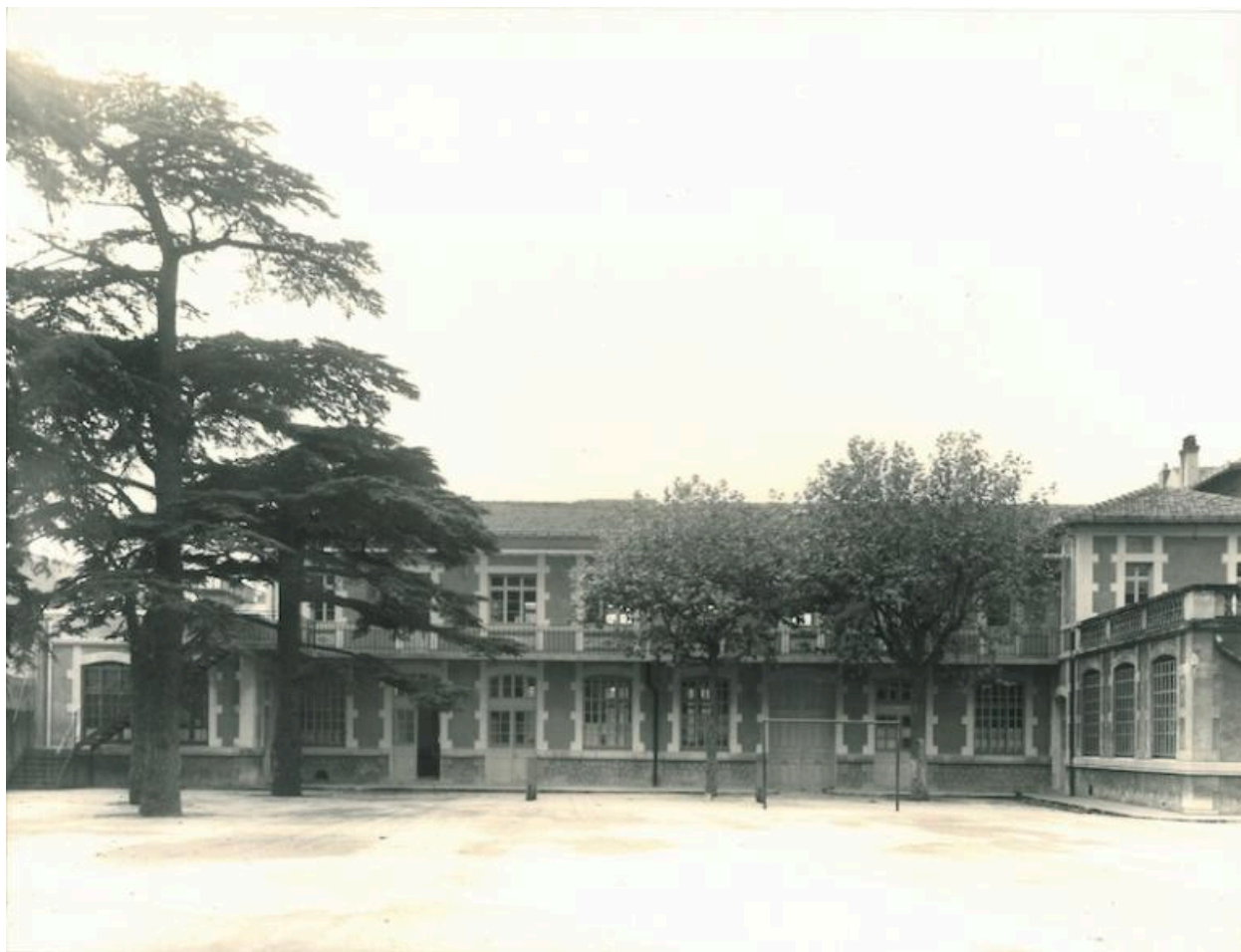
Les bâtiments après travaux, 1958
