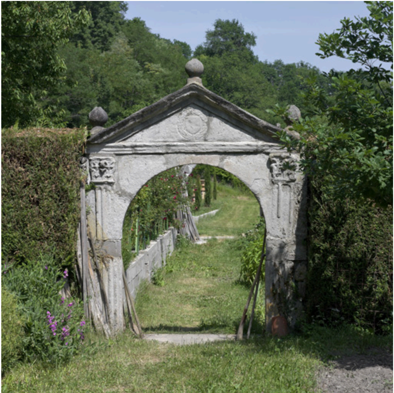
Vue du portail, depuis l'ouest.
