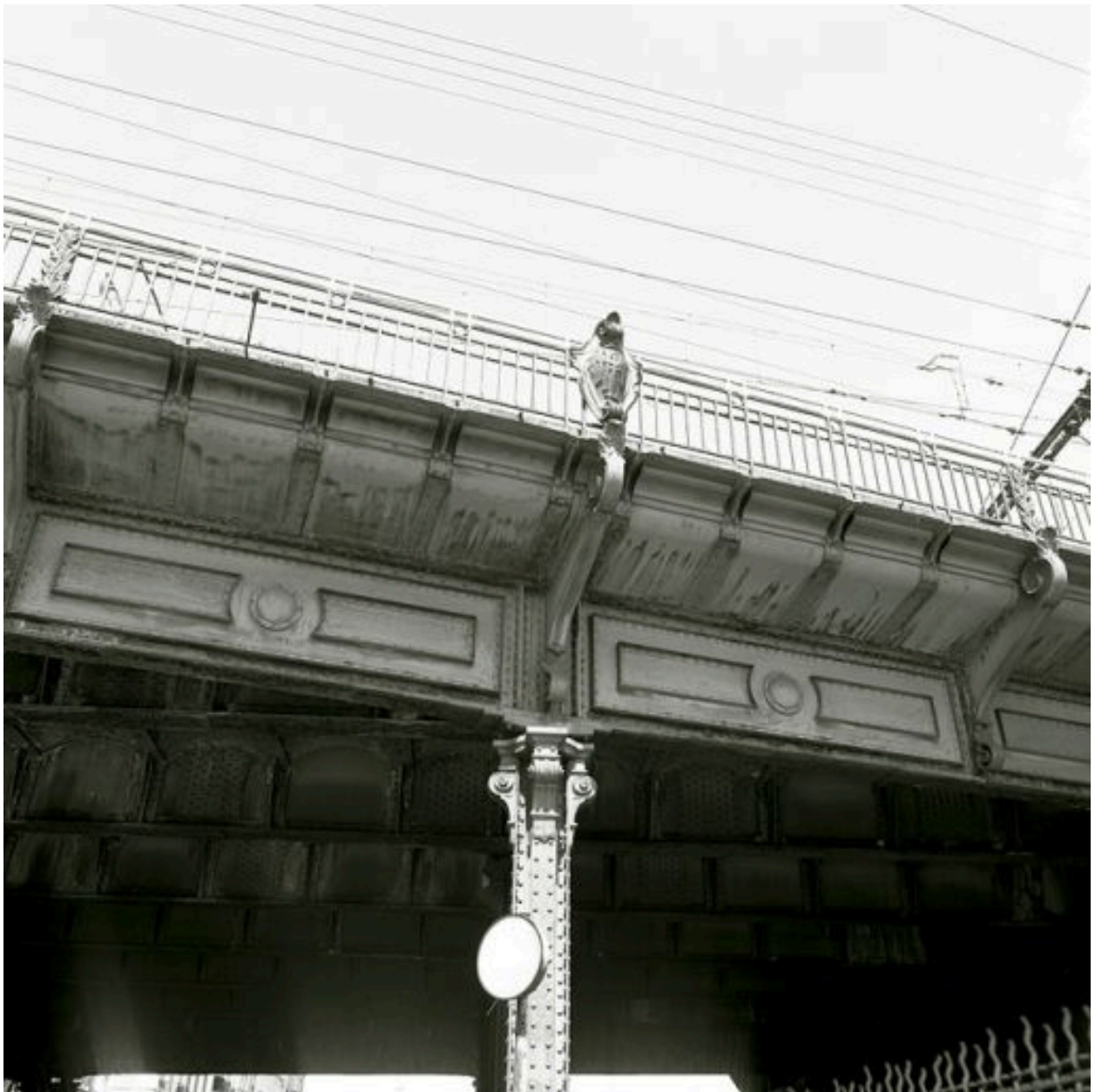
Travée de rive sur le quai Perrache : détail d'une pile et de l'accroche au tablier
