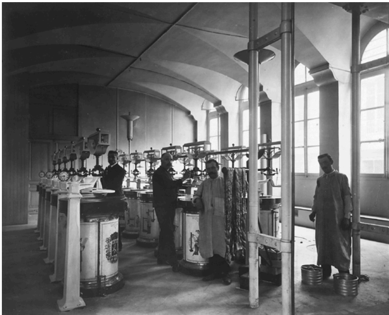
Salle d'Appareils de Conditionnement nouveau système à ventilation forcée - 10 juin 1907
