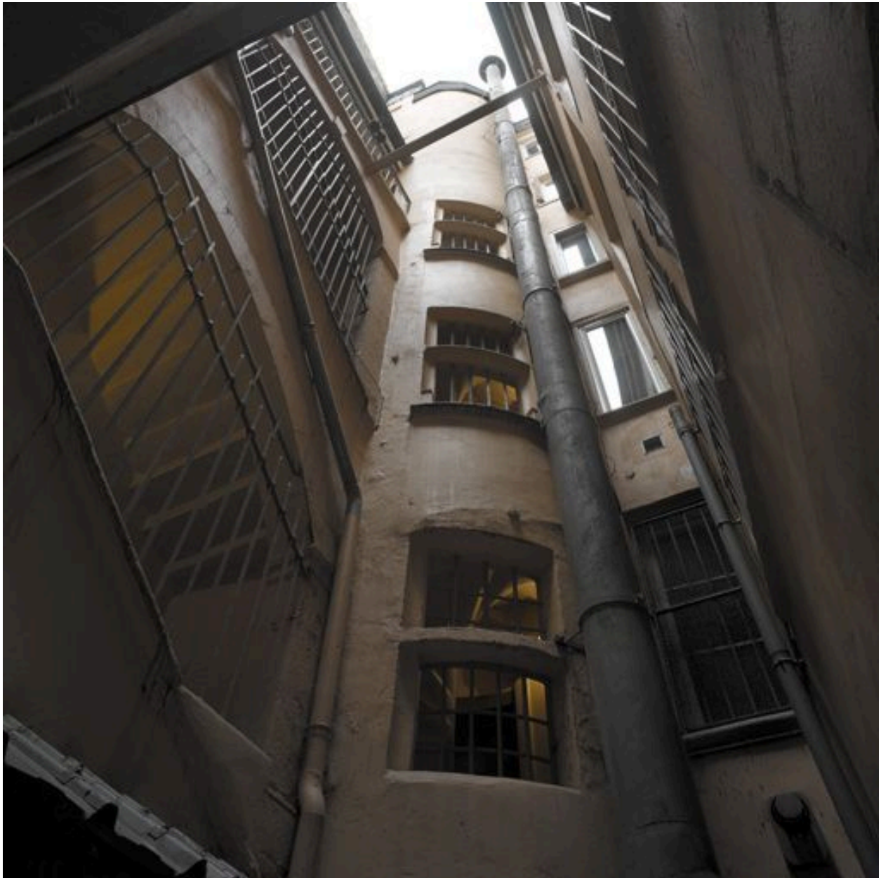
Cour, tour d'escalier au revers du corps sur rue et cage des volées droites de liaison
