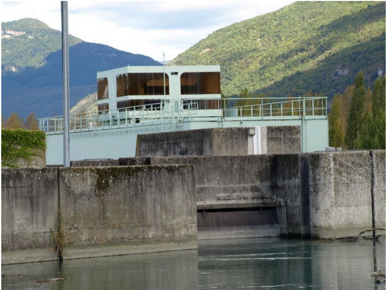
Tour de contrôle, vue partielle amont (depuis la rive gauche)
