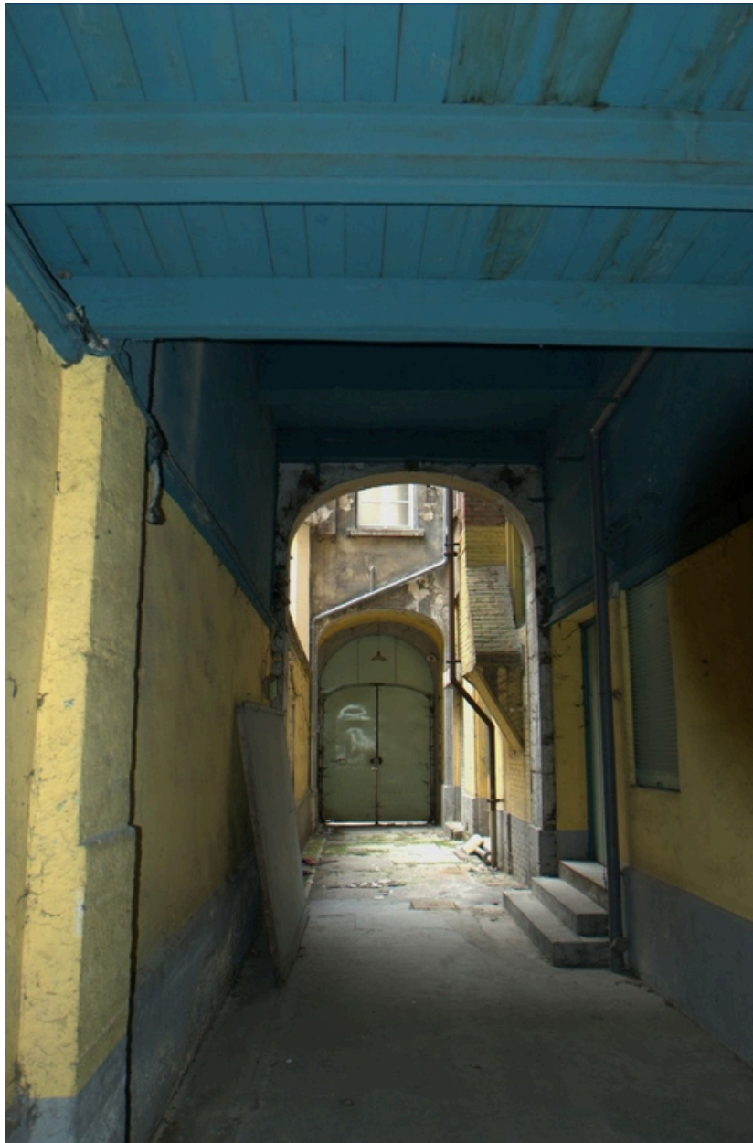
Passage, vue est menant à l'entrée principale
