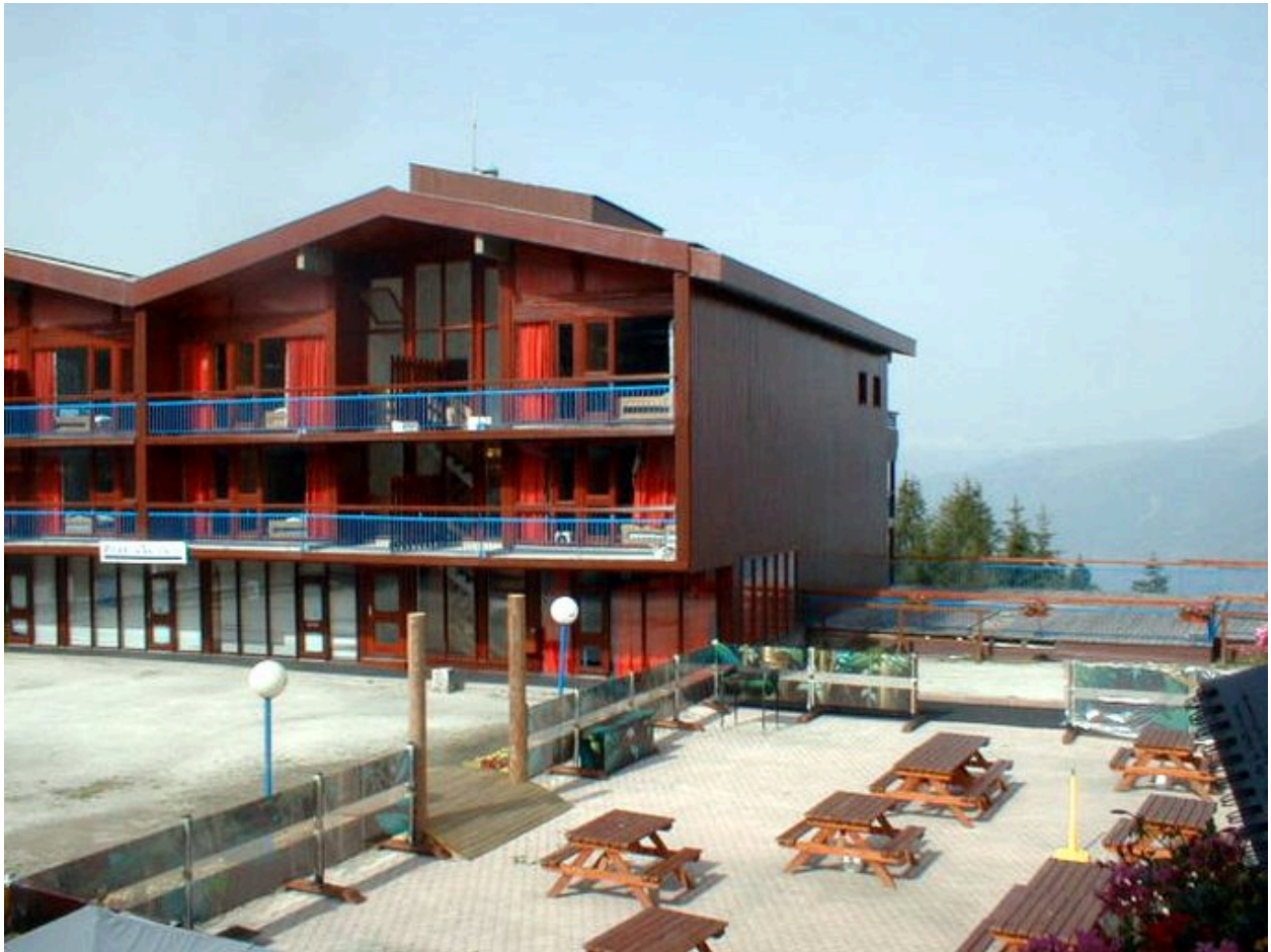
Vue depuis le nord-est, place des Arandelières
