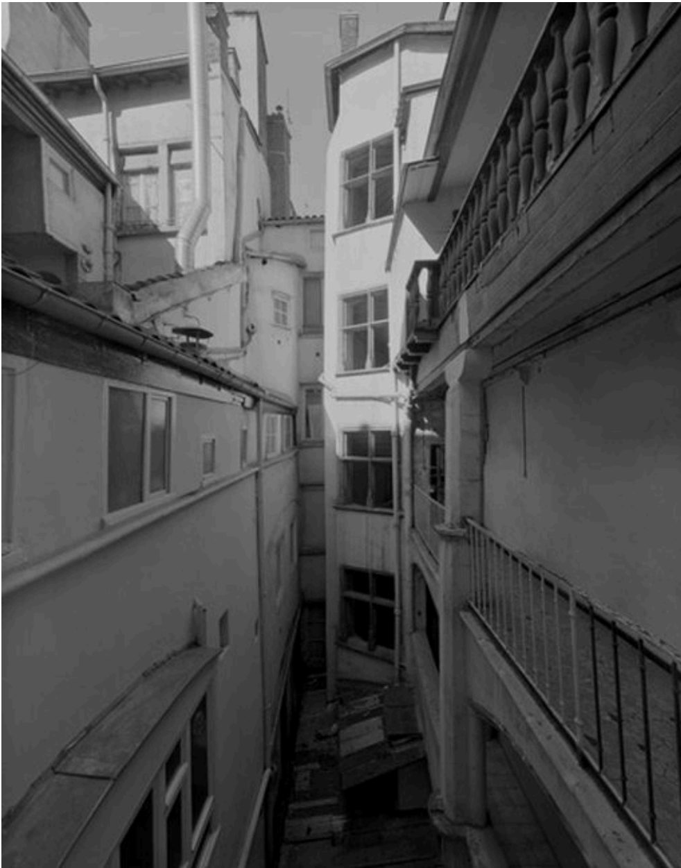
La cage d'escalier et les galeries de circulation depuis le 2e étage carré du corps de bâtiment sur cour
