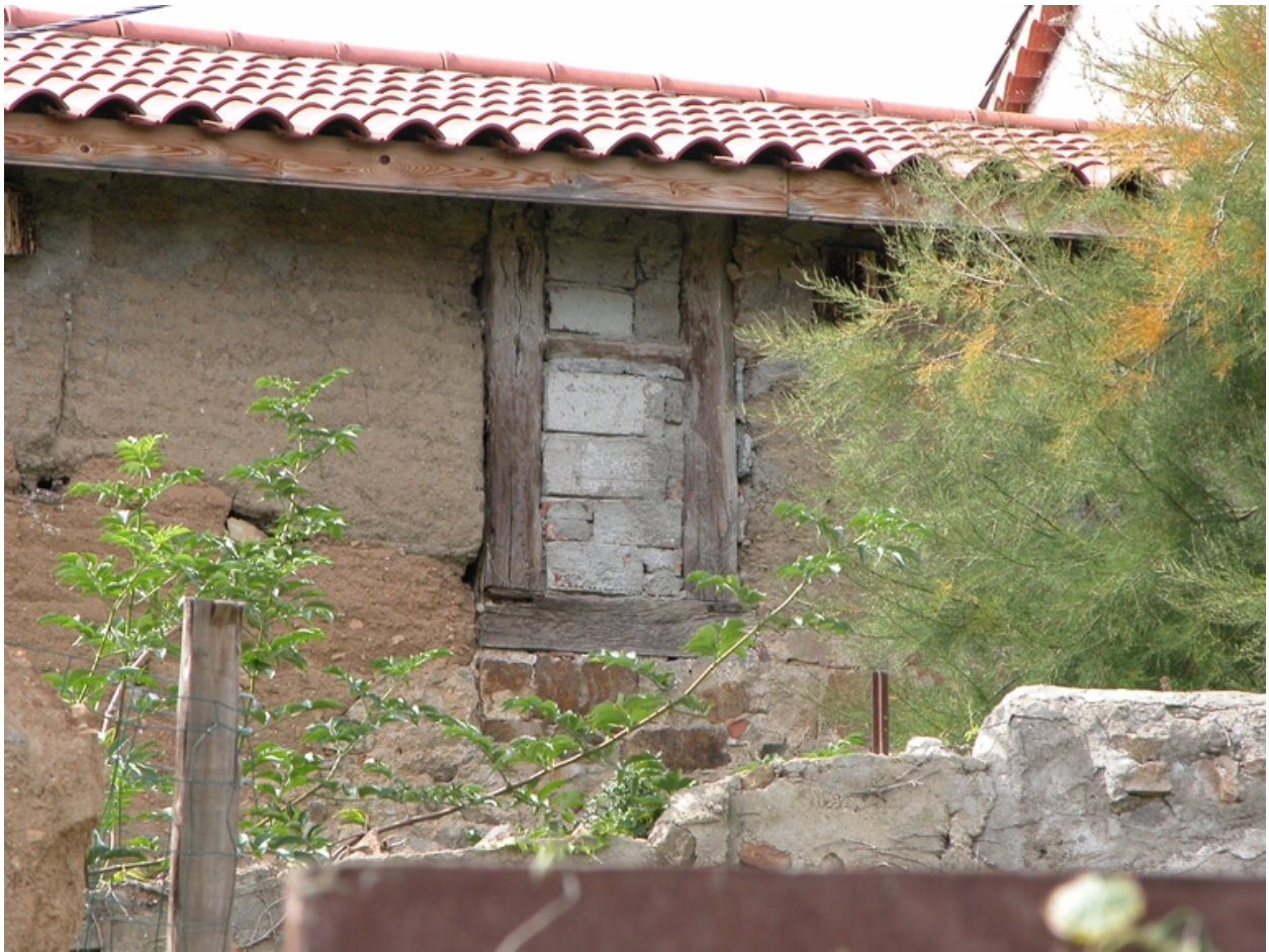
Détail de la fenêtre du grenier du premier logis.
