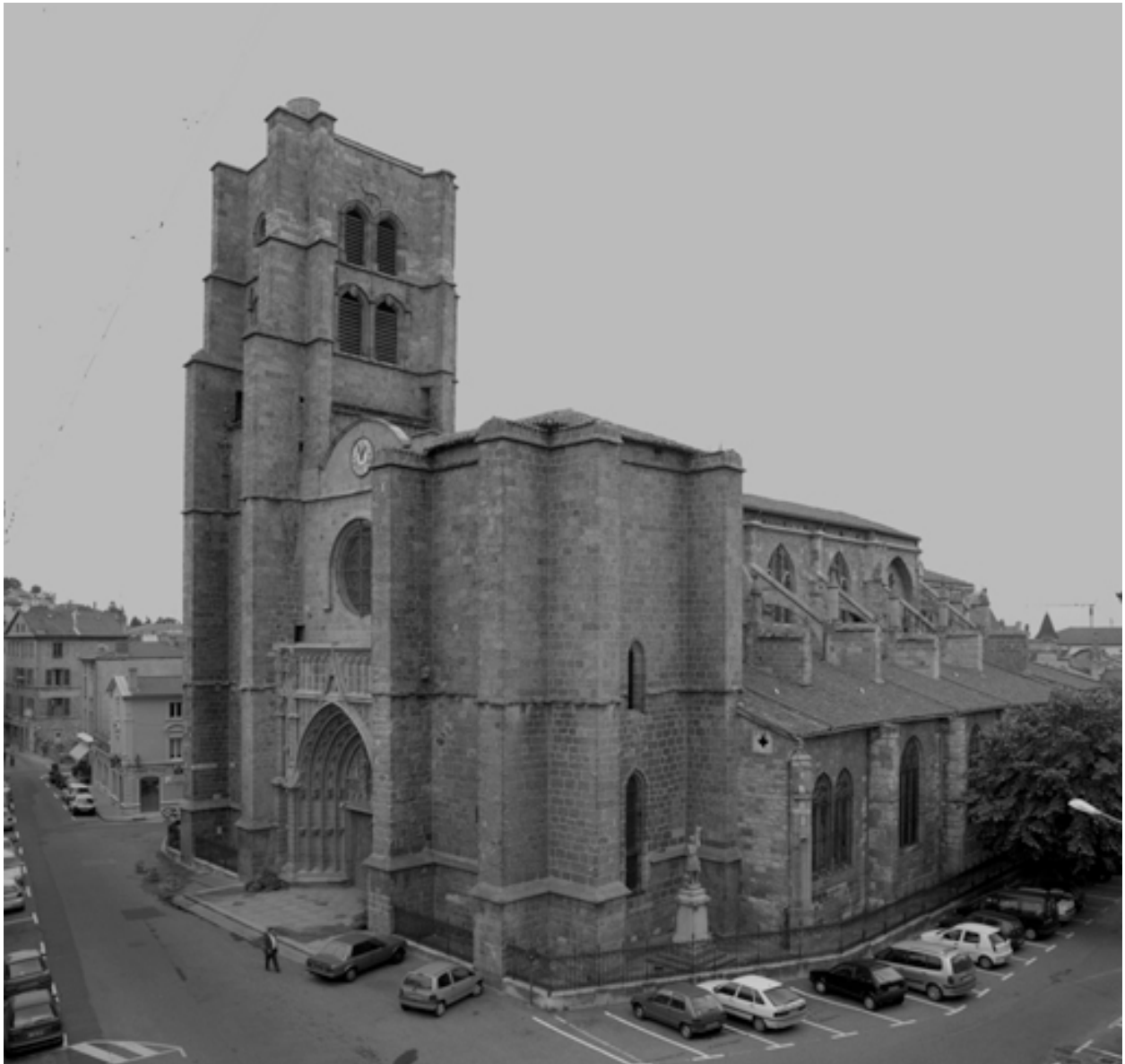
Vue générale de la collégiale de trois-quarts sud-ouest.
