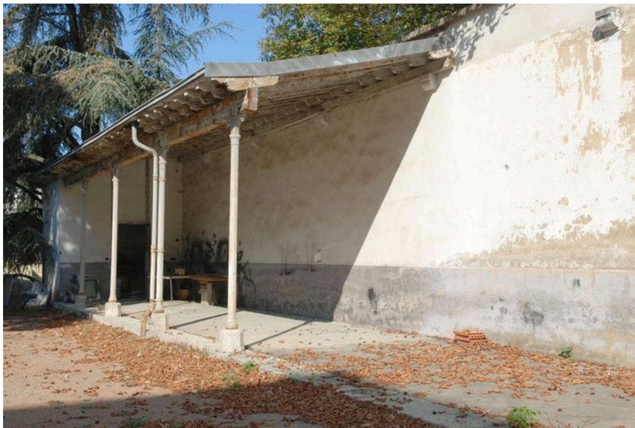
Parc du bâtiment 504 : restes du portique qui reliait l'extrémité nord-ouest du bâtiment à un édicule abritant peut-être les sanitaires
