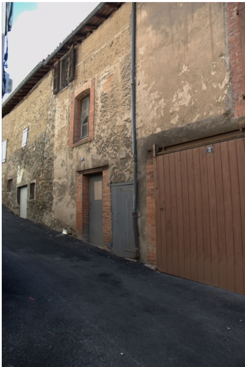
Îlot 3. Ecoles (rue des) 05. Vue générale de la façade sur rue.
