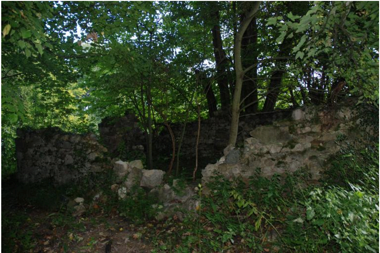
Vue de vestiges de constructions, Sur la Côte (2014 A6 630).
