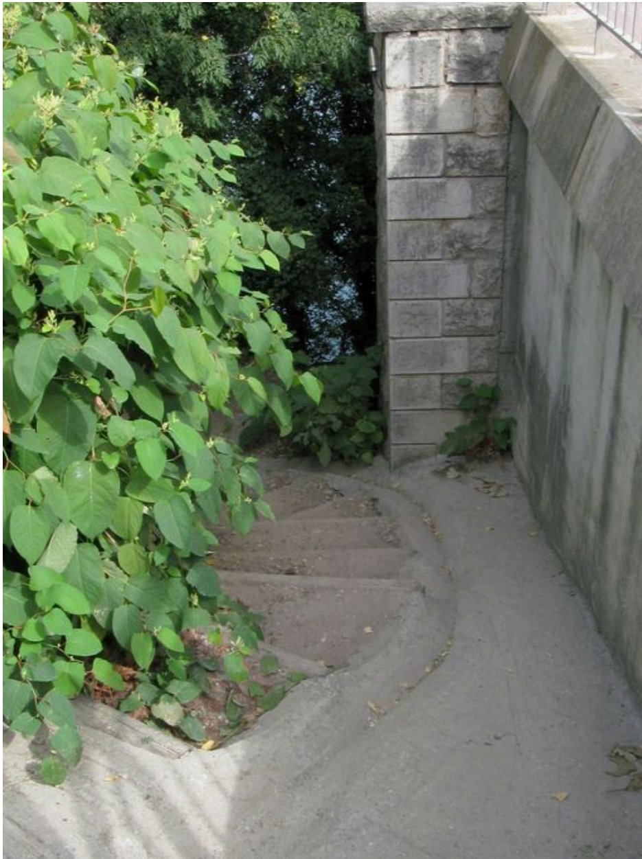
Escalier d'accès à la rive gauche, face aval
