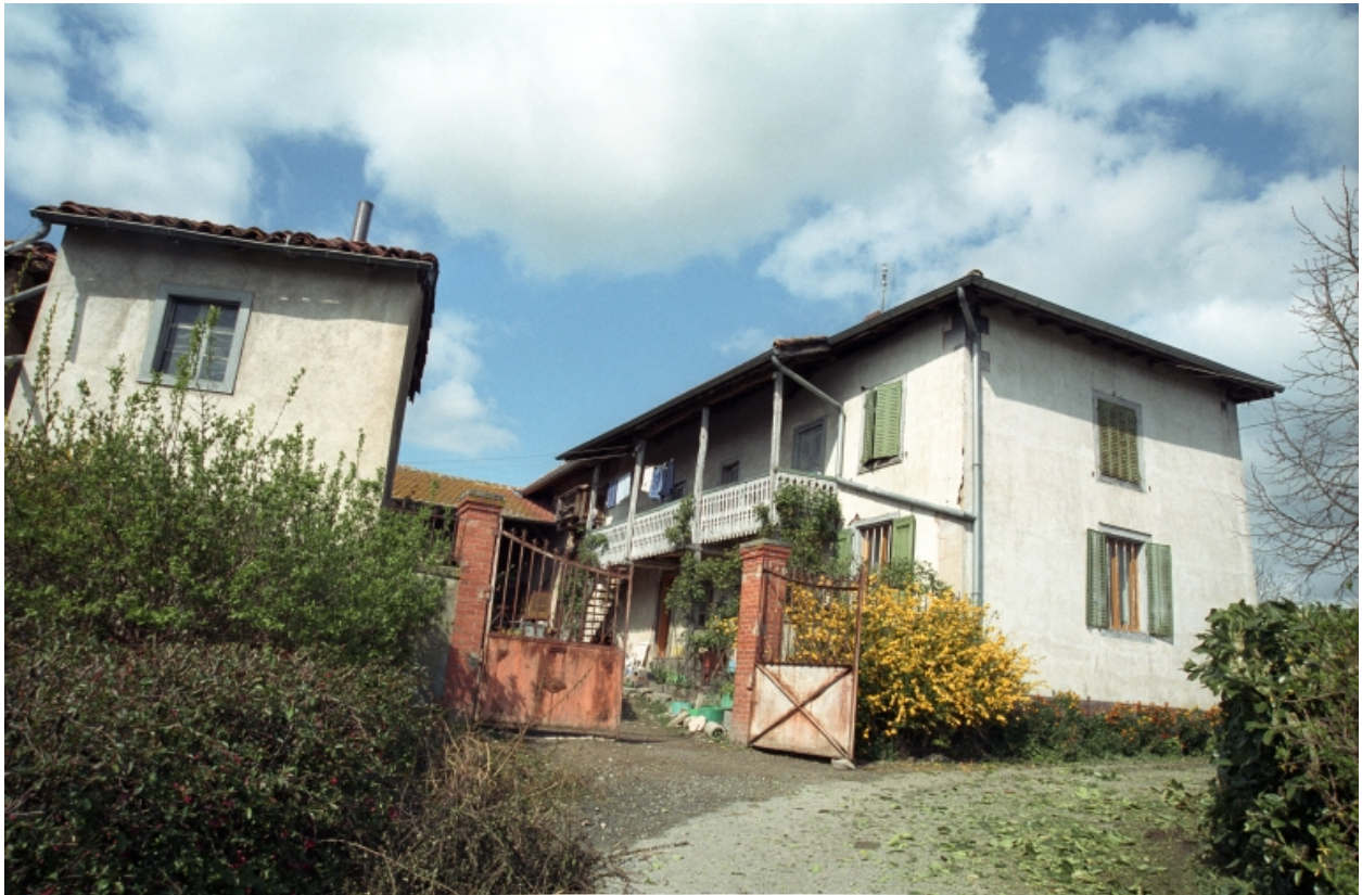
Vue d'ensemble des bâtiments depuis le sud-est.
