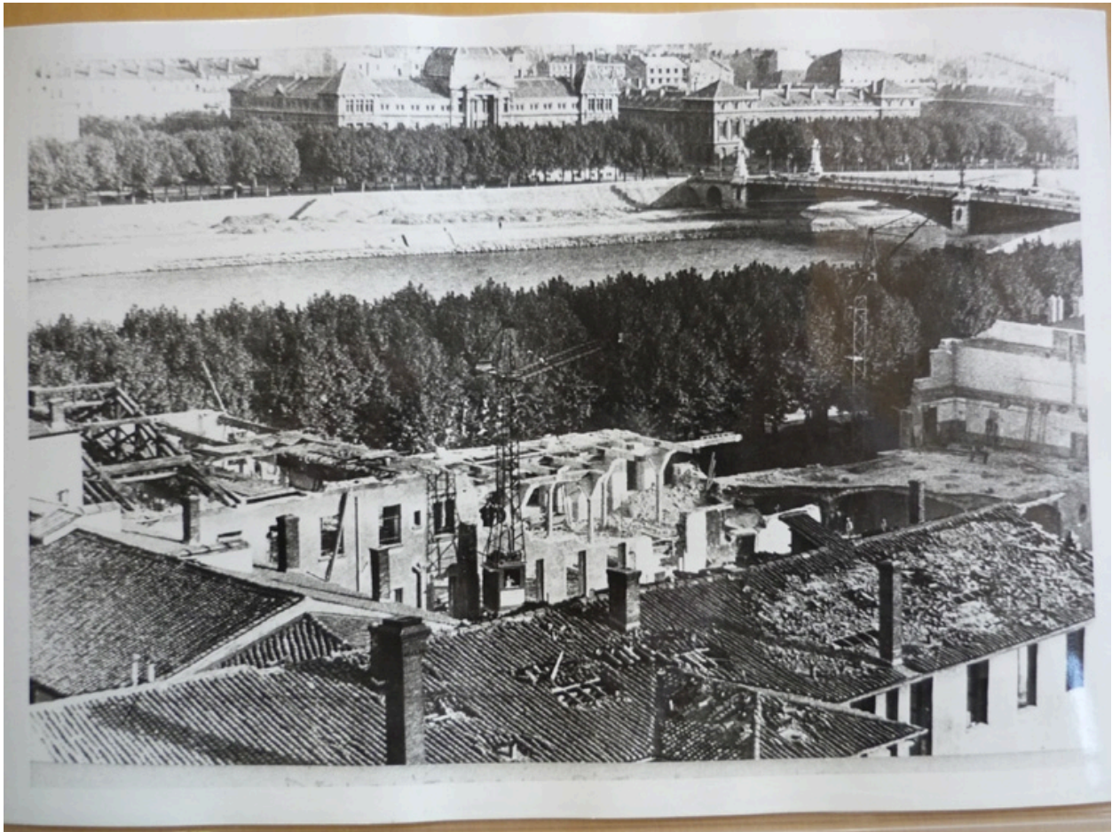
Vue d'ensemble, démolition, 1934 (vue surplombant l'hôpital). Photographie AC Lyon. 2PH31
