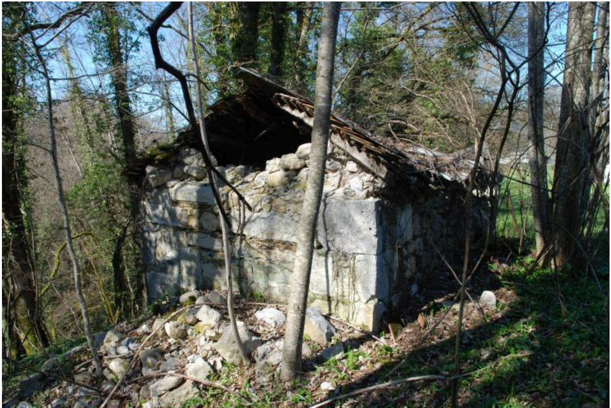
Four à pain, vue d'ensemble de trois-quarts arrière gauche.
