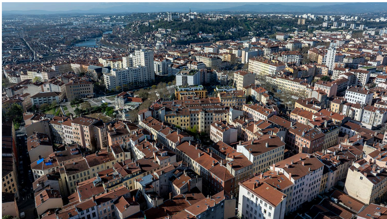
Vue d'ensemble secteur des immeubles-ateliers (vue drone)
