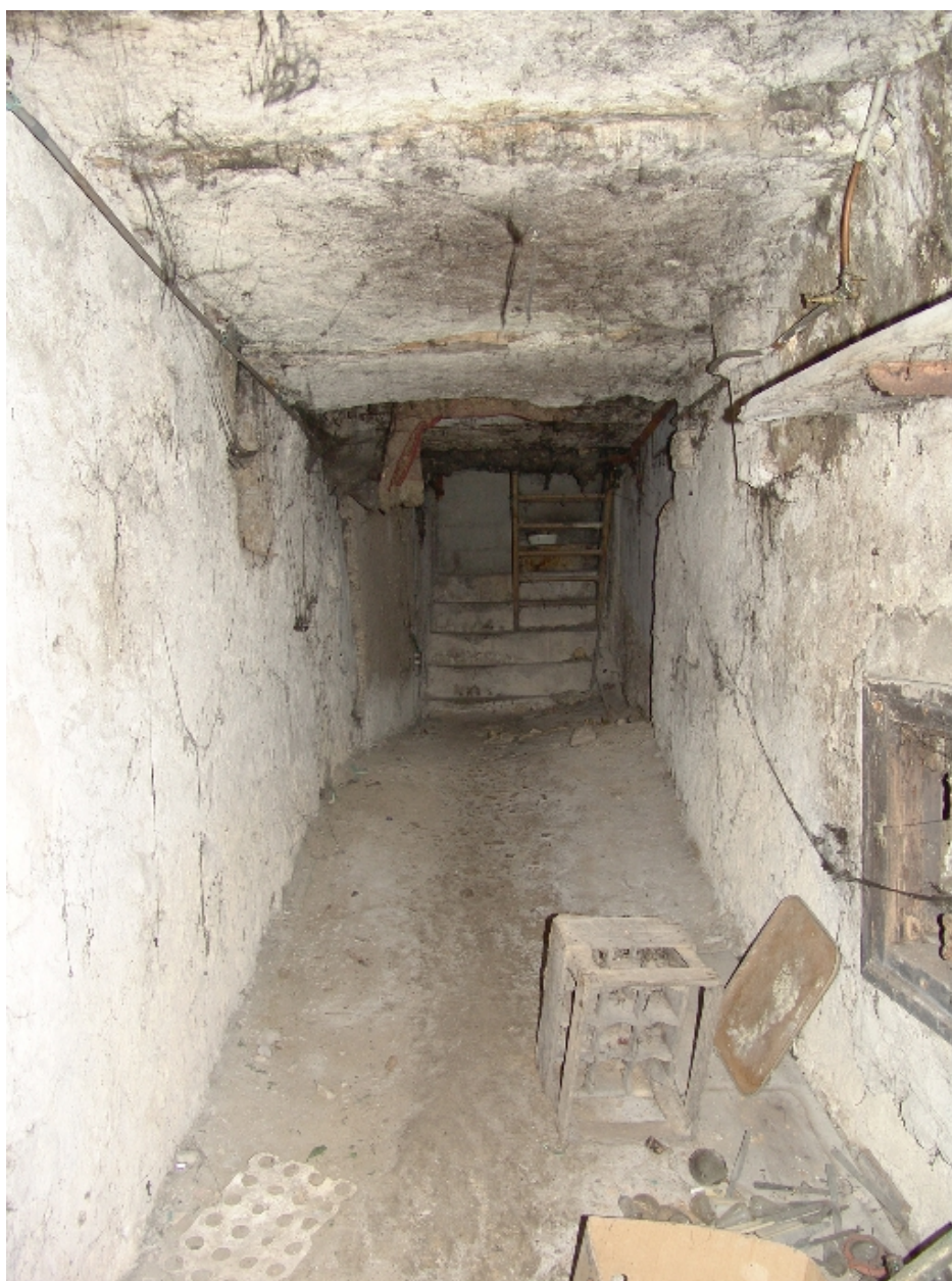
Couloir d'accès aux caves
