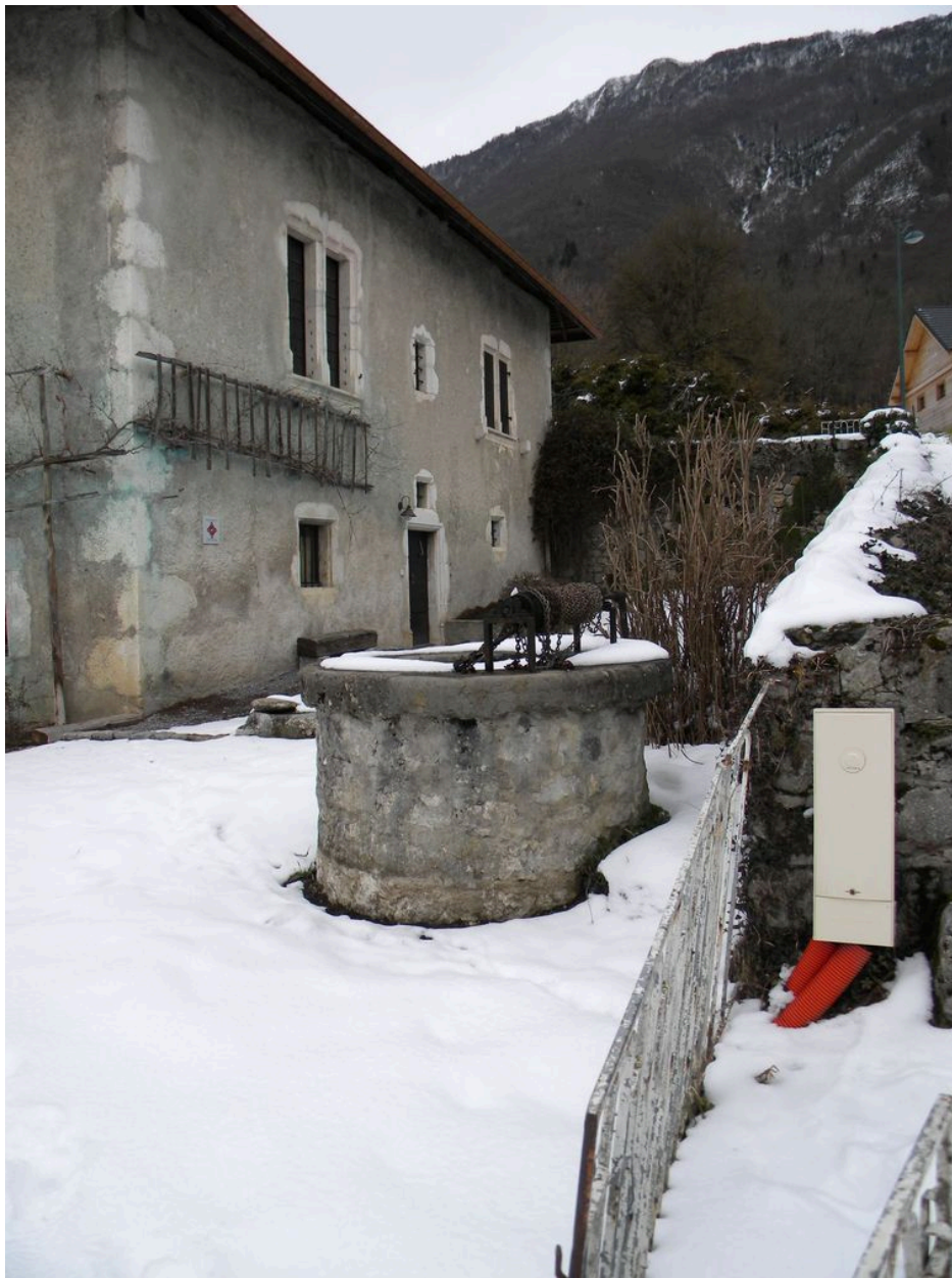
Vue de la façade sud et du puits.
