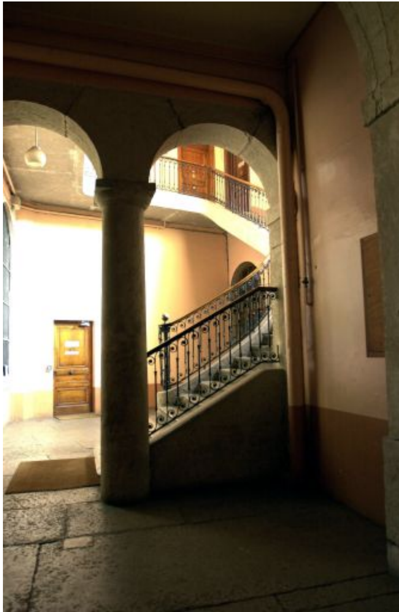
Vue de l'escalier depuis le vestibule
