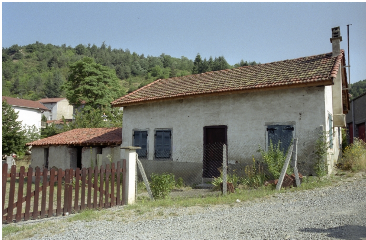
Boën, îlot 21, L'argentière (rue de) - parcelle AP 273. Vue générale de la façade sur cour, depuis la rue.
