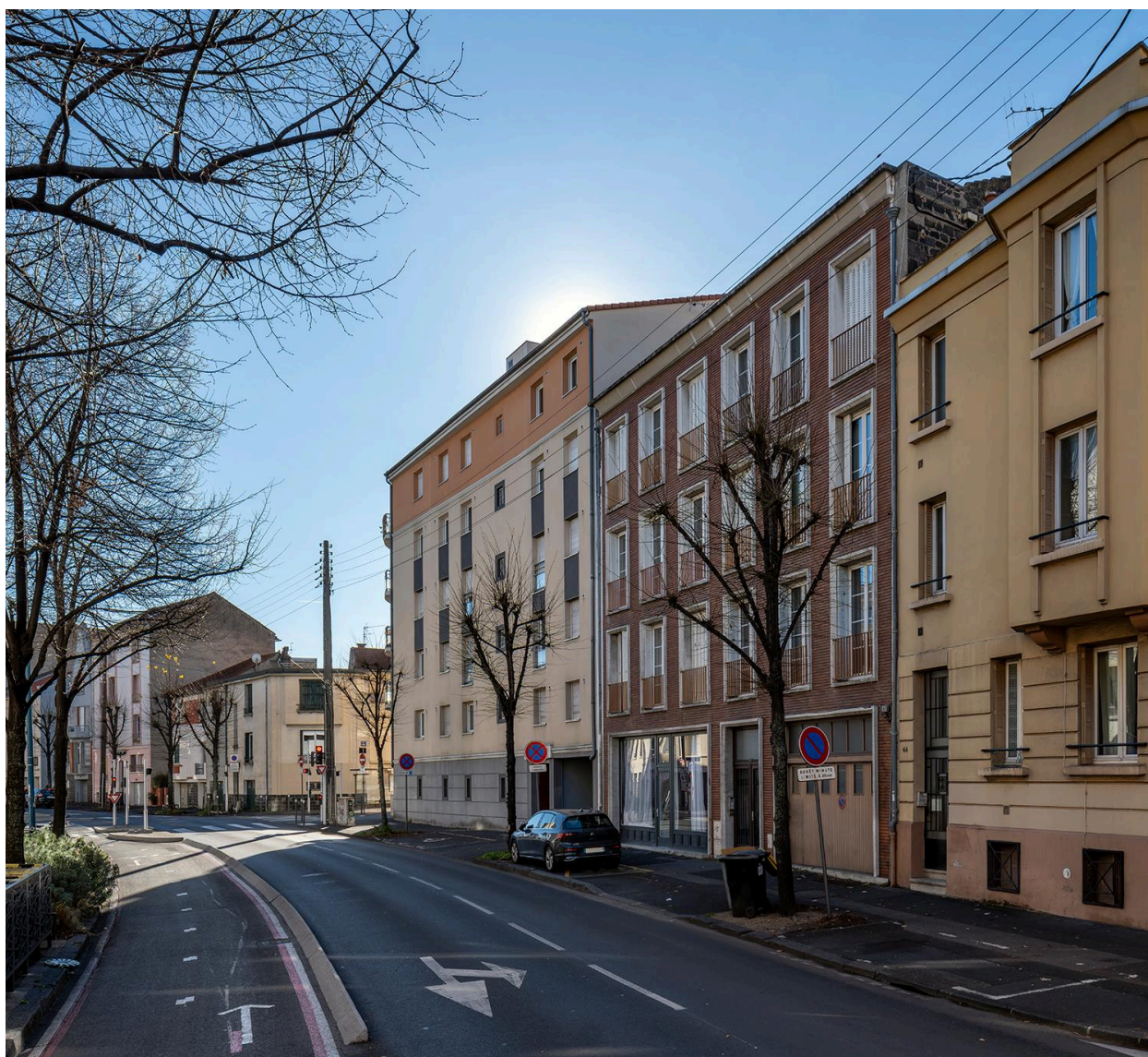
Façades sur le boulevard Aristide-Briand
